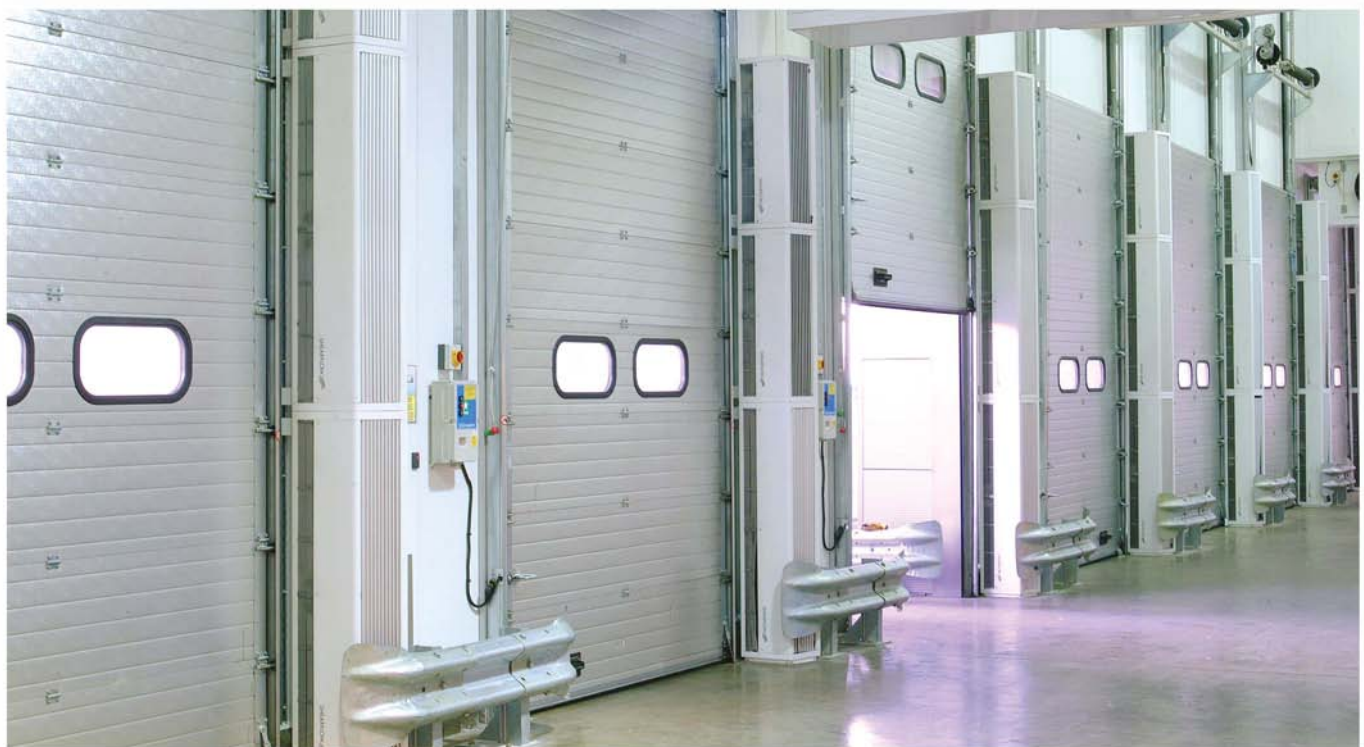
Hűtőházi kivitelű légfüggöny modulok, függőleges beépítése.
